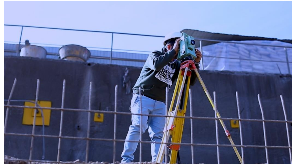
قم- موسسه فرهنگی آیت الله سیستانی عملیات گودبرداری نیلینگ و انکراژ
