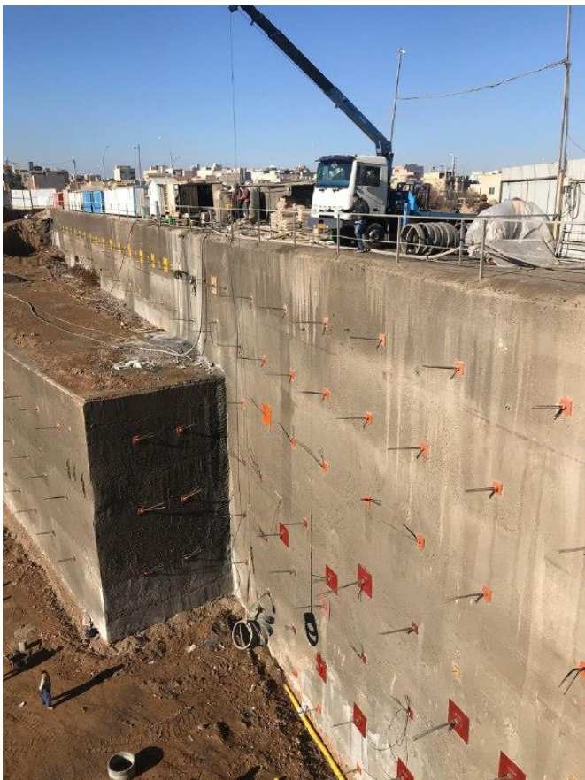
پروژه قم-عمق گود ۲۰متر- کارفرما: موسسه فرهنگی آیت الله سیستانی
