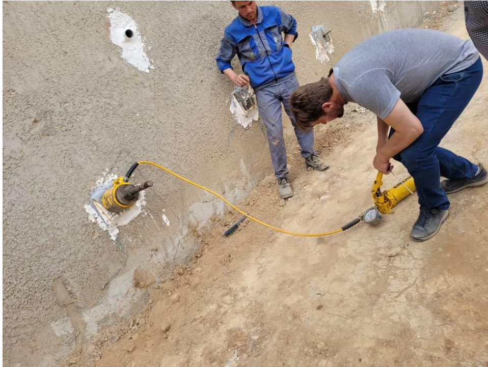
بنای یادبود سردار سپهبد سلیمانی (چیتگر)- عملیات گودبرداری نیلینگ
