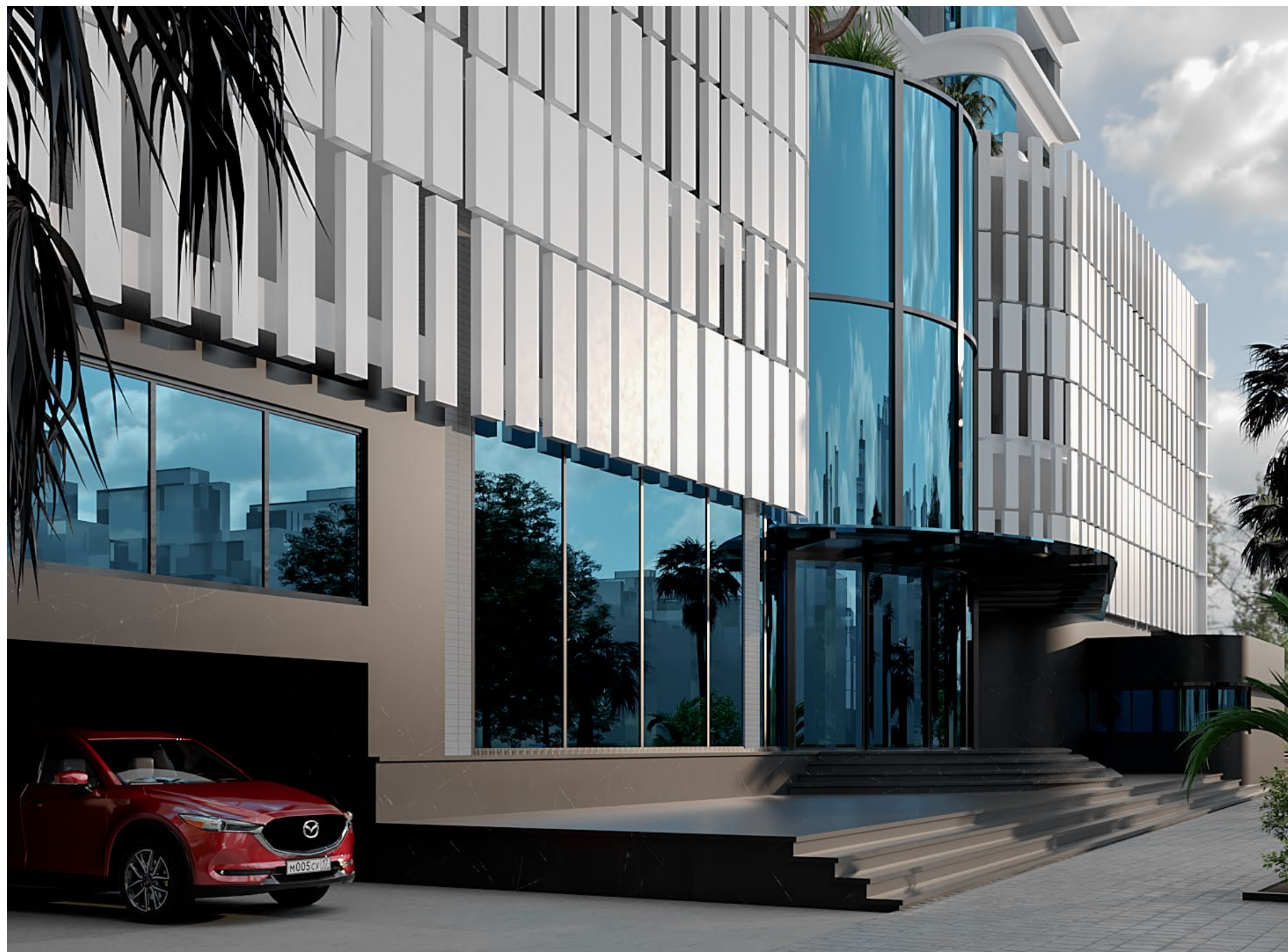
ورودی پروژه-ضلع شمال
